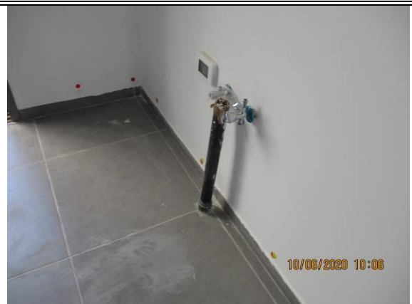
15. כאן בקירות המטבח ע"י מדביקות סומנו נקודות בהם נמדדה הרטיבות באמצעות מד רטיבות
