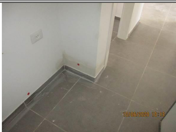
31. רטיבות בקיר הפרוזדור הגובל עם חדר רחצה הורים: כאן טיח הגבס הוחלף לטיח בטון. גם על טיח הבטון התקבלה קריאה גבוהה מאוד (דוגמא נוספת של תיקון קוסמטי)
