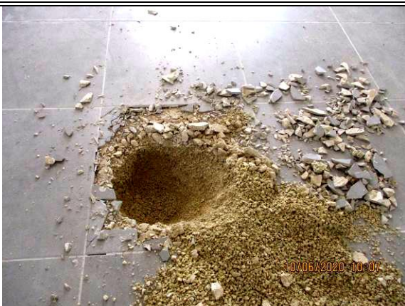
8. אפילו מרחוק ועפ"י הגוון הקהה ניתן להבין שמדובר על סומסום רטוב
