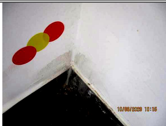
25. כאן בסלון במקום בו התקבלה קריאה גבוהה נמצא צבע שמן מרוח על הקיר
