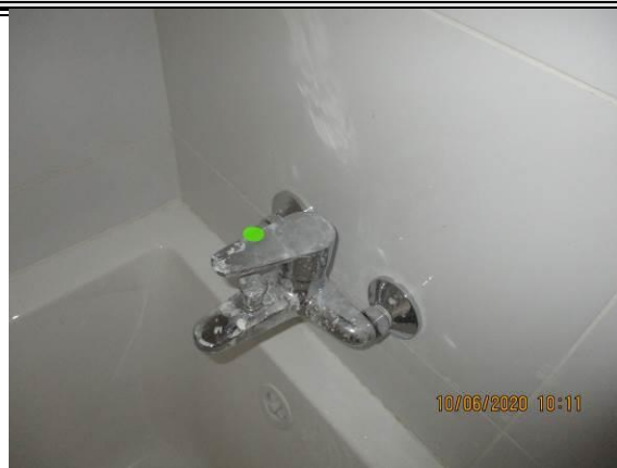
9. חדר רחצה כללי: ברז הסוללה של האמבט לא יציב ומתנדנד
